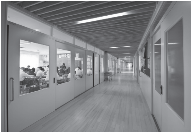
普通教室・廊下。普通教室は多連引き戸 大開口を確保できる
