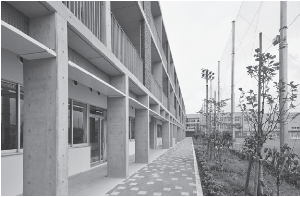
バルコニー。水平ルーバー
